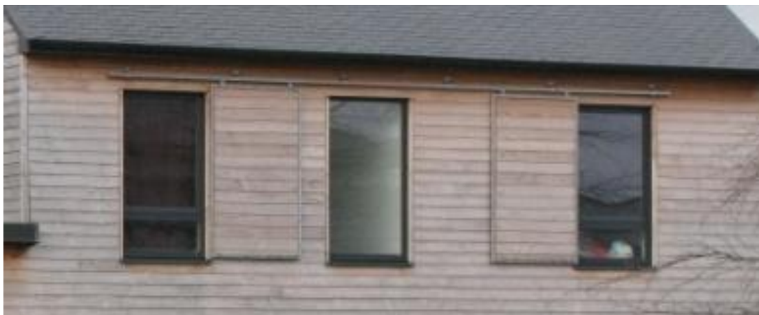
Exemple de protection solaire intérieure contre l'éblouissement
