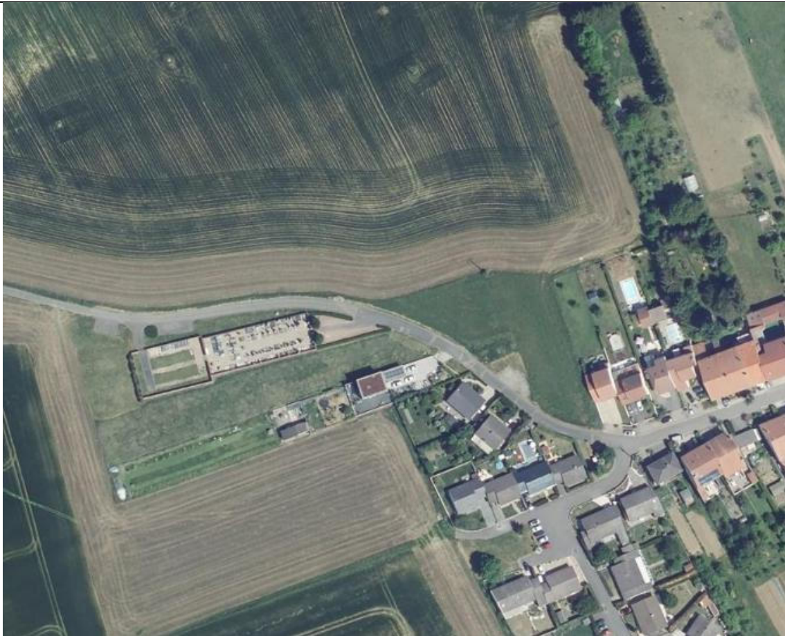
Figure 4 : Vue aérienne de l'OAP Chemin de Metz
