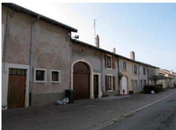
Fermes avec de belles portes en anse de panier le long de la rue principale
