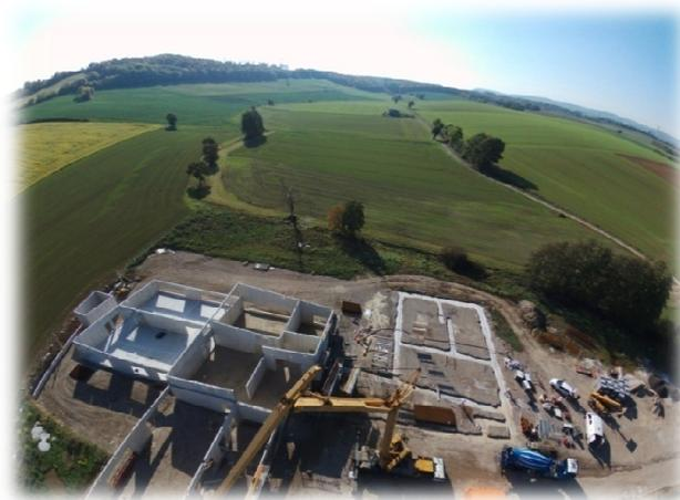
Après les travaux de terrassement et de drainage du terrain réalisés par l'entreprise LINGENHELD, les fondations et les murs en béton armé ont été coulés par l'entreprise COLAS. Toute la partie béton a été finalisée à la mi-décembre, à l'exception de un ou deux petits abris de matériels.
